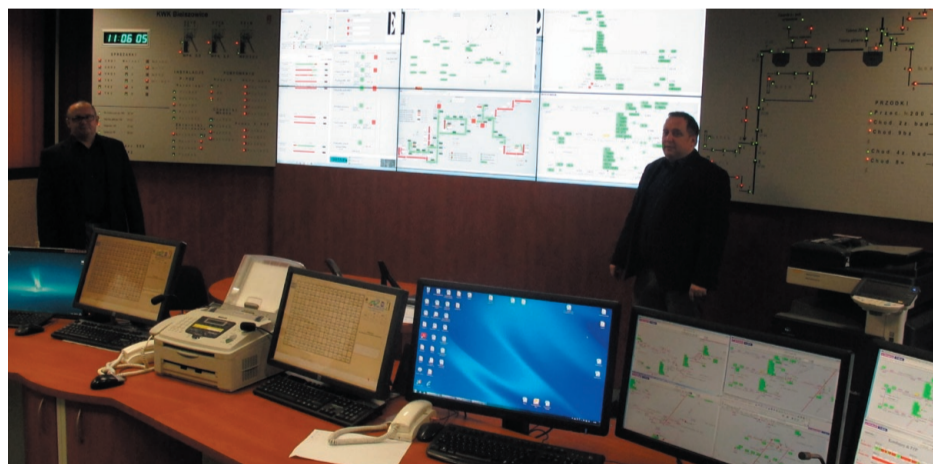
Tablice synoptyczne wyświetlają w sposób niezawodny najważniejsze parametry bezpieczeństwa.
